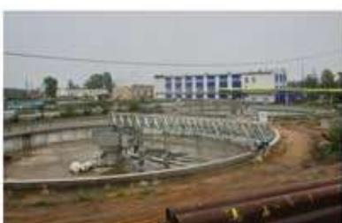
Строительство новой, отвечающей всем современным стандартам, насосной станции возвратного ила и реконструкция воздуходувного блока, вторичных отстойников, аэротенков-смесителей и камеры смешения. Производительность блока биологической очистки составит 170 тыс. м<sup>3</sup>/сутки. Проект реализуется в рамках национального проекта «Экология» и регионального проекта «Оздоровление Волги».
