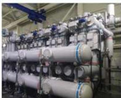
Реконструкция узла присоединения электрической сети АО «Соликамскбумпром». Выполнены строительные работы, поставка оборудования, монтажные работы и пусконаладочные работы. Строительство с «0» цикла закрытого распределительного устройства 110кВ «ГПП-5» выполнено по схеме «Две рабочие системы шин». Количество присоединений РУ 110кВ — семь. Наличие среди производственных потребителей АО «Соликамскбумпром» потребителей первой категории электроснабжения.
