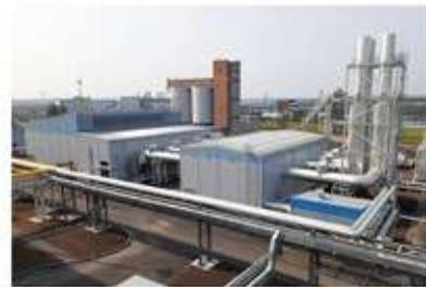
25 июля 2019 года РОТЕК сдал реконструированную Соликамскую ТЭЦ мощностью 55 МВт, обеспечивающую электроэнергией и теплом одного из лидеров бумажной промышленности России – АО «Соликамскбумпром», а также потребителей в городе Соликамск. Общая мощность электростанции 54,96 МВт; Сооружена электростанция на базе 3-х газопоршневых агрегатов типа 18V50SG по 18,3 МВт производства финской фирмы Wärtsilä
